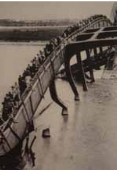
Hilfssteg bei Floridsdorf, 1945 www.wikiorg.com/vienna_donau453.jpg
