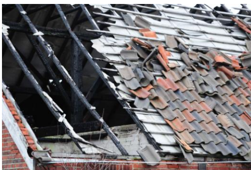
sanierungsbedürftiges Dach
